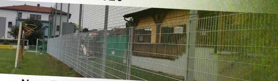
Neu-Errichtung der Ballfang-Anlage
